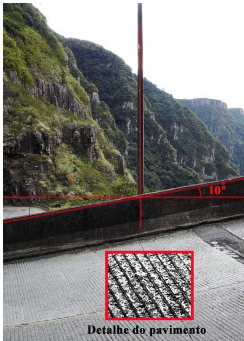
Figura 4 – Rampa com inclinação excepcionalmente grande (10° ou 18%) em um trecho da Rodovia SC 480 na Serra do Rio do Rastro.
