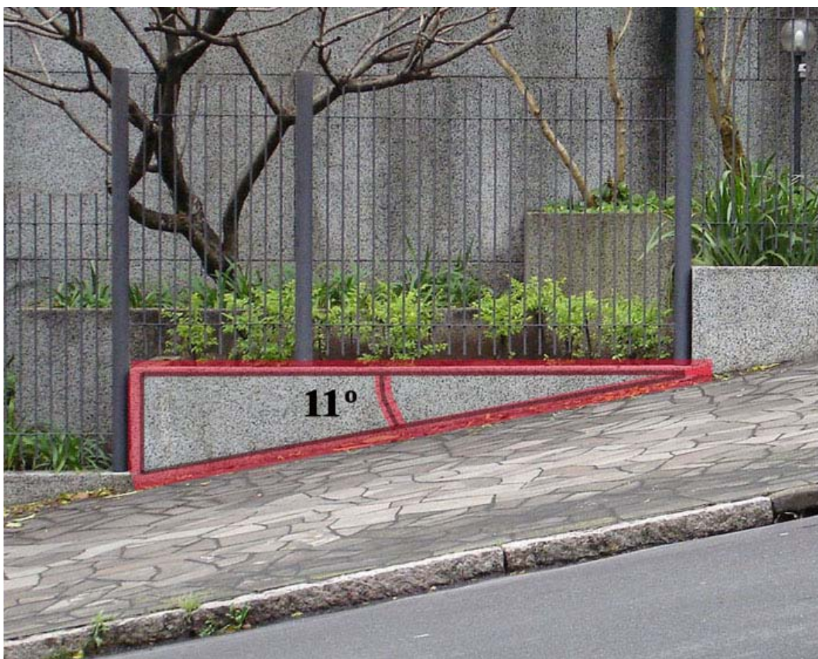
Figura 2 – Nas edificações no entorno da rua encontramos indicadores da vertical e/ou horizontal.
