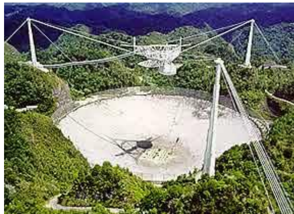
Figura 14.06: O radiotelescópio de Arecibo, o maior do mundo, com diâmetro de 305 m, é a principal fonte de dados do projeto SETI.
