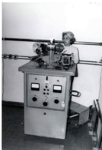
Yvonne Mascarenhas com o primeiro gerador para difração de raios X do Departamento de Física da Escola de Engenharia de São Carlos (1958). (Foto 1).
