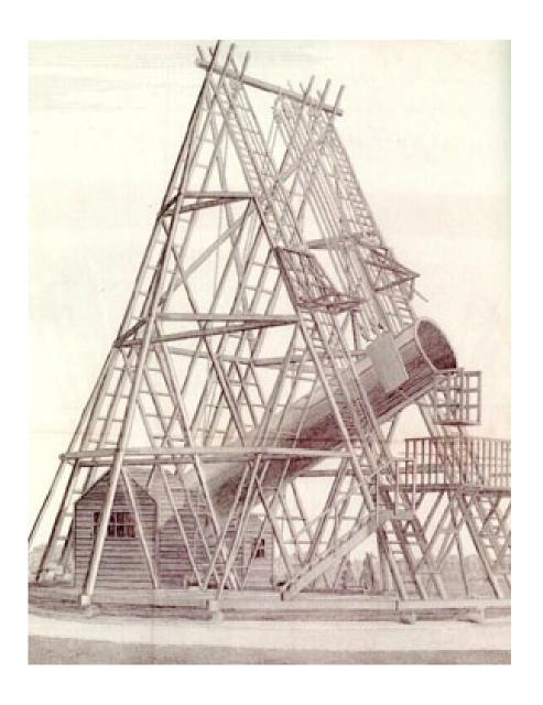
Em 1789 Herschel construiu um enorme telescópio refletor com comprimento focal de 40 pés e cujo espelho tinha o diâmetro de 48 polegadas (imagem ao lado).
